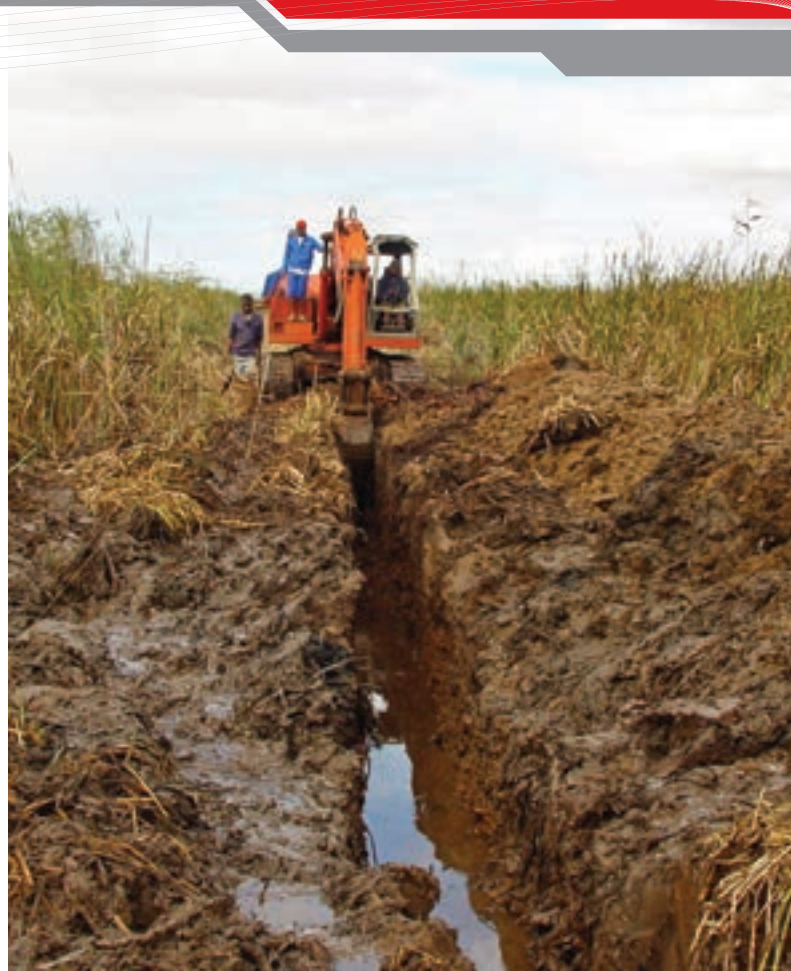
▲ Installering van dreineringspyp in versuipde landerye.
